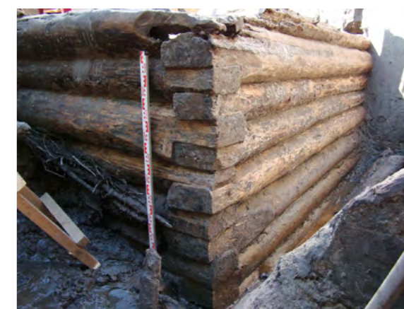
Деревянная башня-донжон Ландскроны. 1300 год. Законсервирована на месте. Раскопки 2006–2009 годов. Фото с сайта «Спасем Охтинский мыс».
