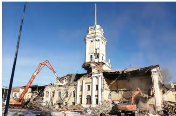
Снос бывшего здания НИМИСТ. 05.03.2022. Фото с информационного ресурса «Градозащитный Петербург».
