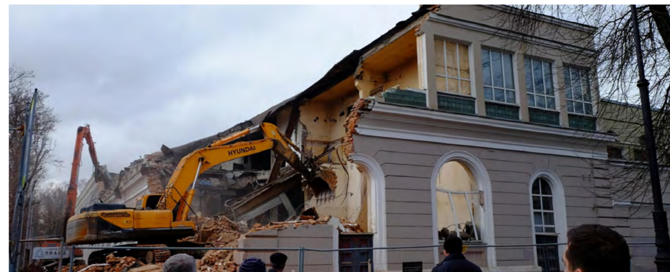
Снос здания бывшего Манежа лейб-гвардии Финляндского полка по адресу: Санкт-Петербург, 20-я линия В.О., д. 19. 08.04.2022. Фото с информационного ресурса «Градозащитный Петербург».
