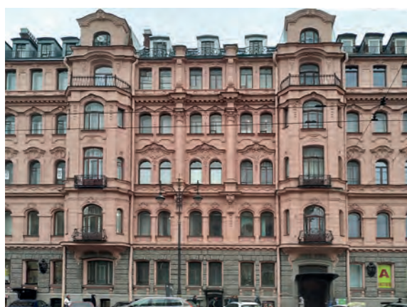
Дом Ю.Б. Бака (ул. Кирочная, д. 24). В ходе реставрации в 2019 году были утрачены некоторые декоративные элементы (в частности – кованые козырьки над входными дверями), изменен цвет стен и др.
