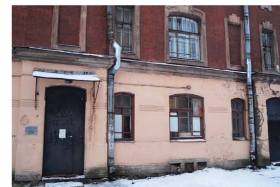
СПб ГБУЗ «Санкт-Петербургская городская дезинфекционная станция» (ул. Профессора Ивашенцова, д. 5).
