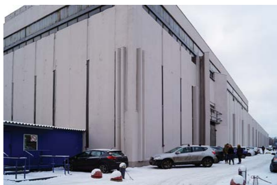
ООО «Завод «Стальконструкция»» (Литовская ул., д. 17 лит. А).
